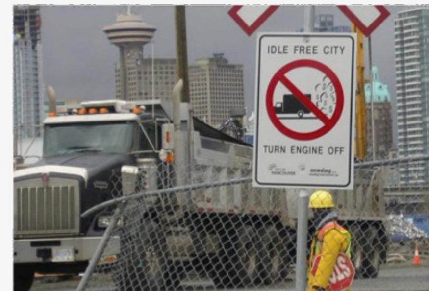
Figura 12. Cartel de obra con medidas sostenibles
