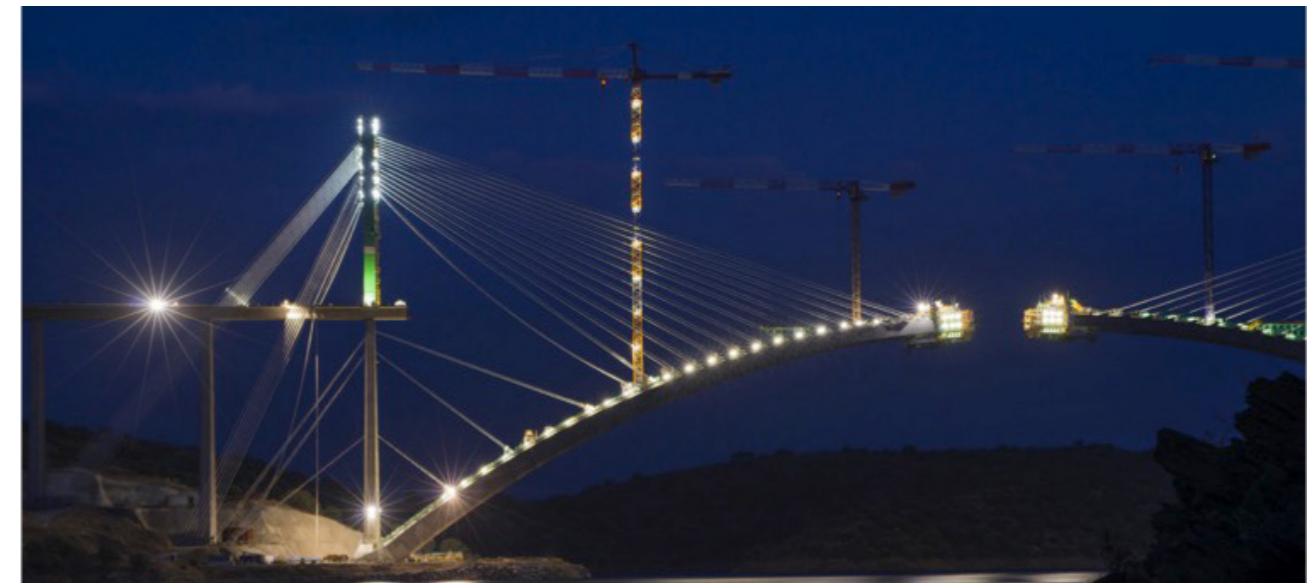
Figura 2. Optimización en el empleo de materiales, en el impacto sobre el entorno y el empleo de recursos, con la robustez técnica y las soluciones estructurales necesarias para garantizar prestaciones, resistencia, durabilidad, resiliencia. (Viaducto de Almonte)
