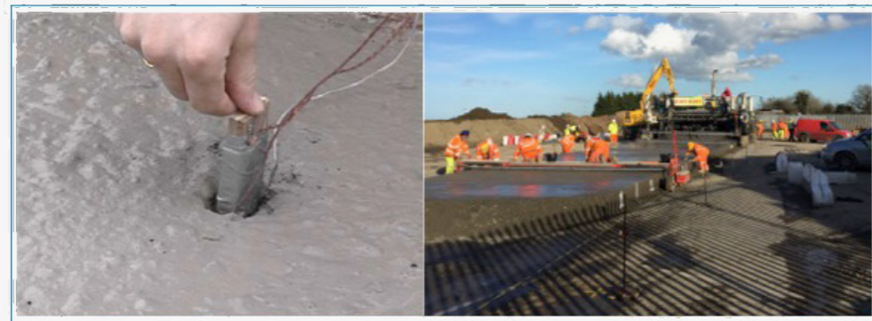
Figura 11. Ejecución de tramo de prueba e instalación de termopares
