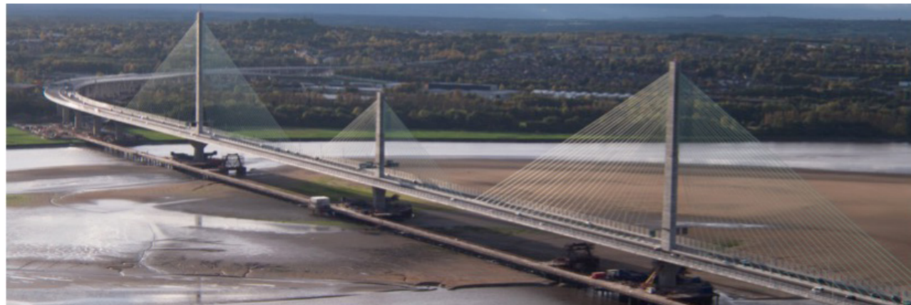
Figura 1. Las infraestructuras vertebran el territorio estableciendo nexos y articulando el espacio en un compromiso entre medio ambiente, sociedad y economía (Puente de Mersey).
