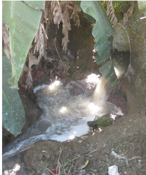
FIGURA 124. VERTIDO DIRECTO DE AGUAS RESIDUALES A LA CAÑADA PONTEZUELA
