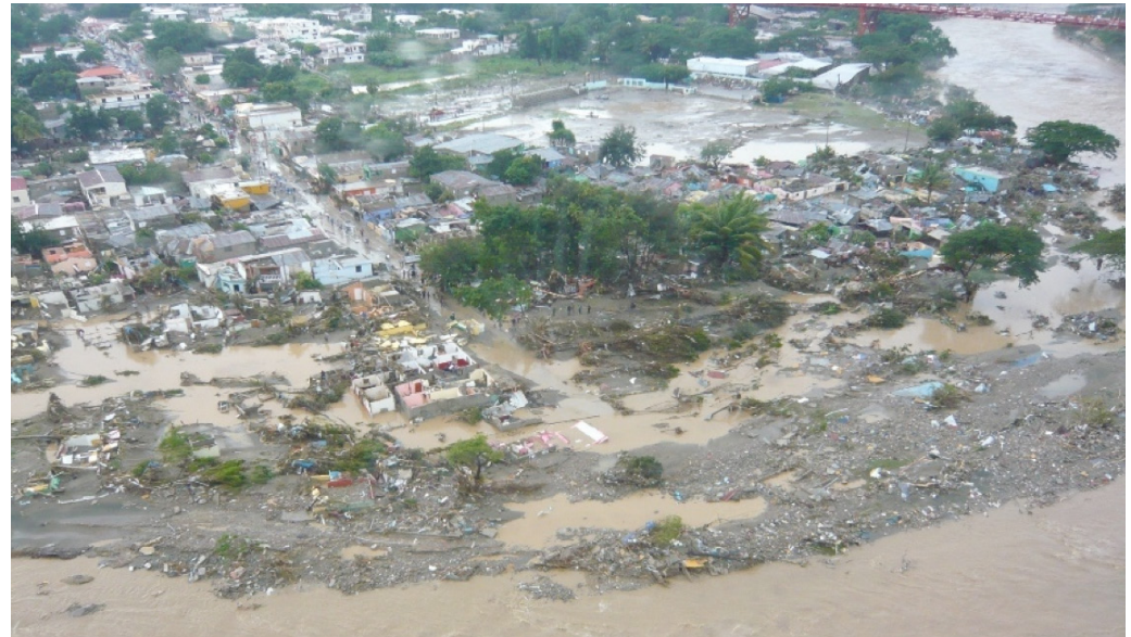
EFFECTOS DEL DESASTRE OCURRIDO EN DICIEMBRE DE 2007 EN LA DEPURADORA DE AGUAS RESIDUALES DE CORAASAN (ARRIBA) Y EN LA ZONA DE BELLA VISTA (ABAJO). FUENTE: COMISIÓN DE SANTIAGO
