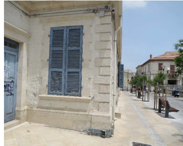
MEDIDAS DE REFUERZO ESTRUCTURAL PARA DAÑOS SÍSMICOS: TENSORES DE HIERRO
